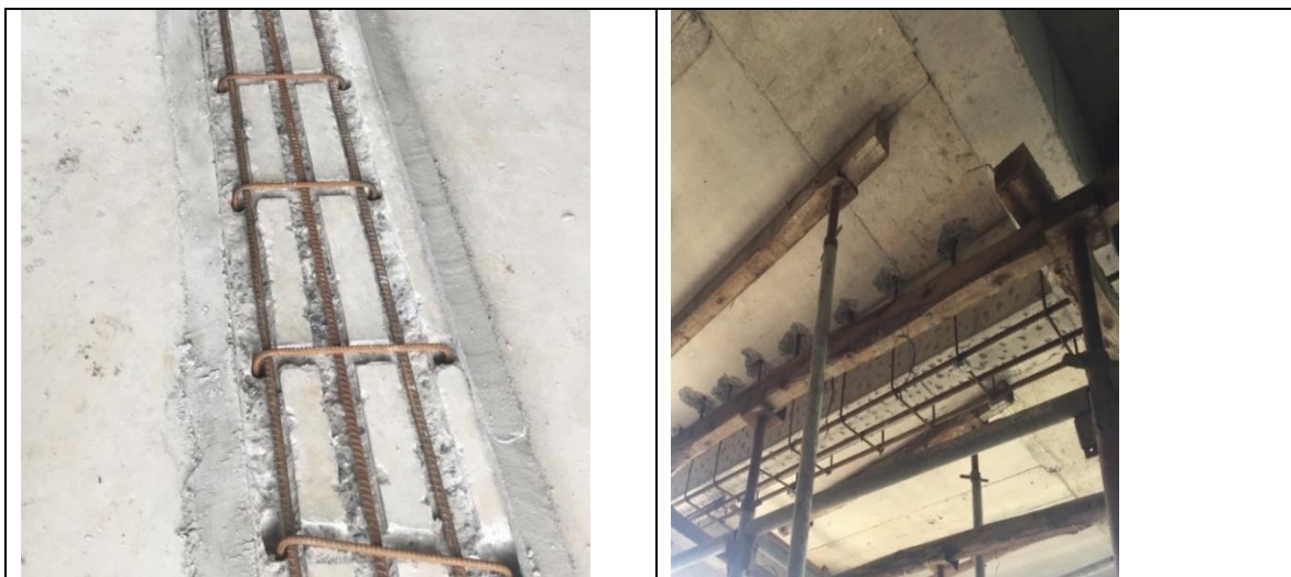
Hình 8. Thi công gia cường để bù tăng tiết diện BTCT
