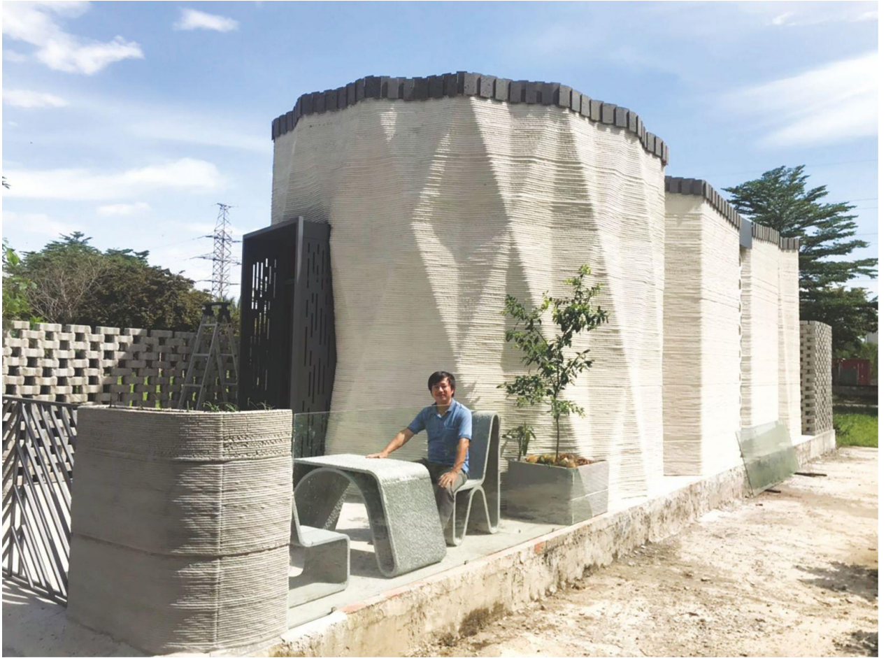
Công trình đầu tiên in 3D ở TP.HCM, kích thước 5 \times 14m và cao 4m .
